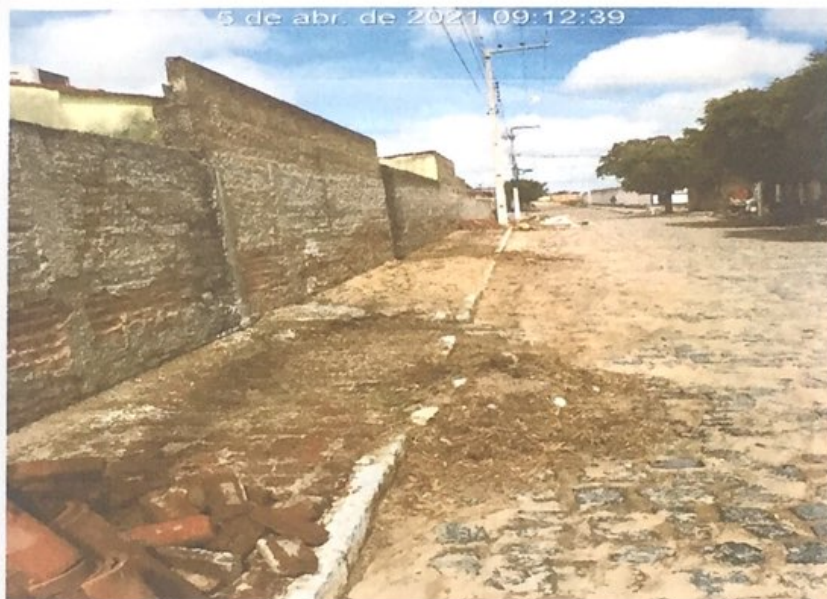
Foto 04: Lateral da Fachada- calçada a executar.
