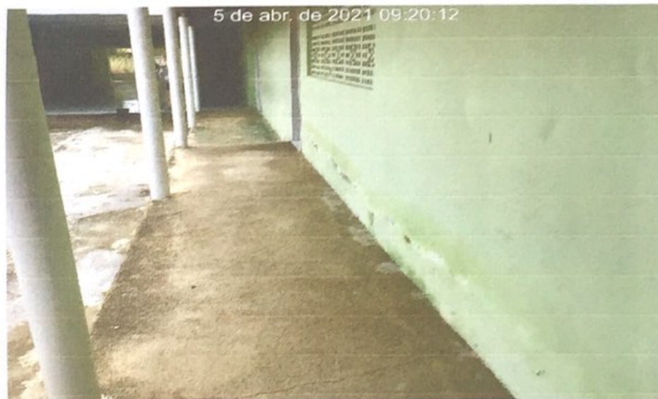
Foto 10: Área de Circulação.
