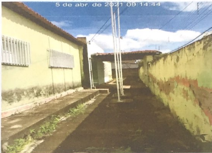
Foto 07: Rampa para demolição e reconstruir com inclinação, no máximo 8,33%.
