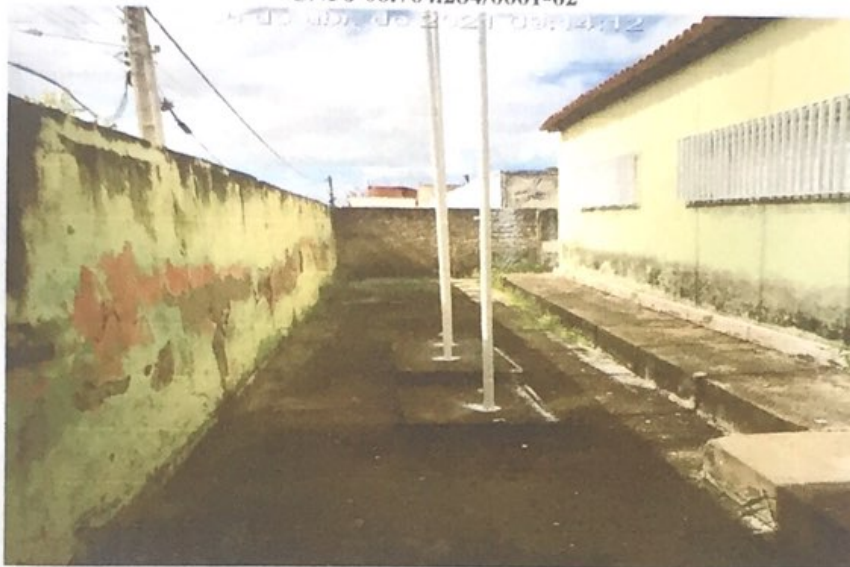
Foto 05: Lateral Interna da Fachada.
