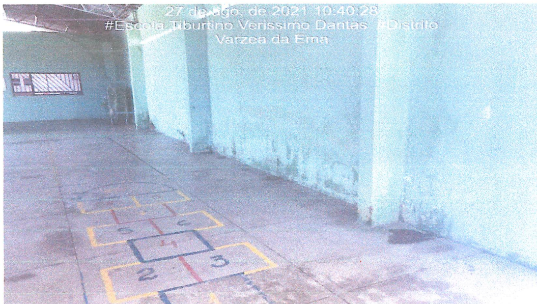
Foto 09: Auditório bancos a ser construídos.
