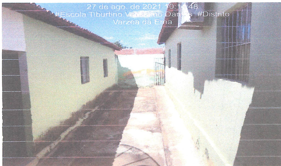
Foto 10: Área externa a ser pintada e revestida até 1,10m.
